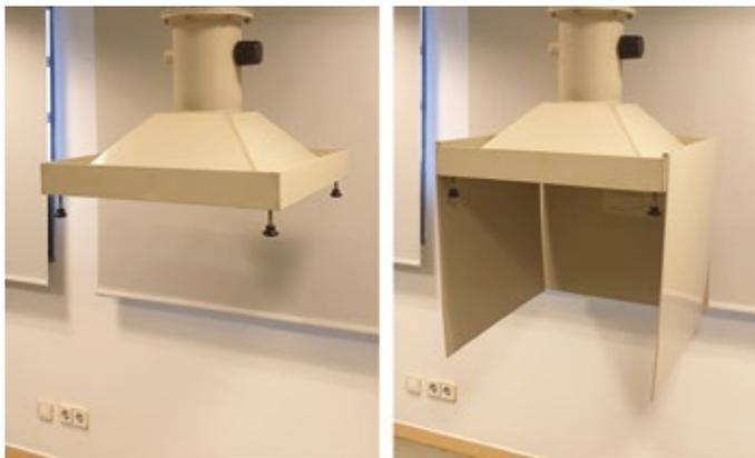
El tipo de geometría y diseño de la campana tiene su influencia en el cálculo del caudal necesario para tener una adecuada velocidad de captación y, por tanto, en su eficacia.
