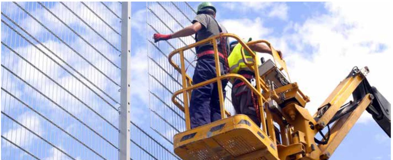
**Chasis.-** Es la base de la plataforma. Puede ser autopropulsado, empujado o remolcado. Asimismo, puede estar situado sobre el suelo, ruedas, cadenas, orugas o bases especiales e ir montado sobre remolque, semi-remolque, camión o furgón. Su estabilidad vendrá por ejes exteriores, estabilizadores, gatos u otros sistemas similares.
