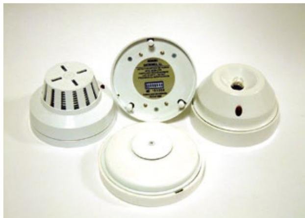
El elemento característico de la instalación es el detector de incendios. Según la Norma UNE EN 54-1 (UNE 23007 parte1) es el “componente de un sistema de detección de incendio que contiene, al menos, un sensor que controla de manera continua o a intervalos regulares, un fenómeno físico y/o químico asociado a un incendio y que emite una señal al equipo de control y señalización”.
