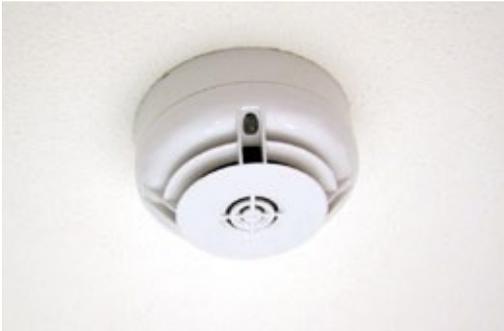
No deberán montarse detectores (que no sean de haz óptico) a menos de 500 mm de cualquier muro o tabique. Cuando los locales estén divididos en secciones mediante muros, tabiques o estanterías de almacenamiento que lleguen a menos de 300 mm del techo, las divisiones deberán considerarse como si llegaran al techo y las secciones se considerarán como locales separados. Deberá dejarse un espacio libre por debajo de los detectores y en todas las direcciones de, como mínimo, 500 mm.
