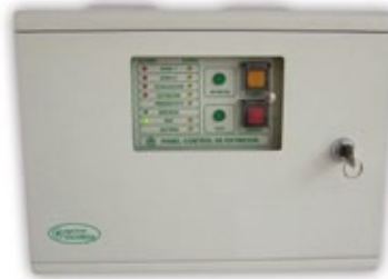
Panell de control d'un sistema d'extinció automàtic connectat al sistema de detecció d'incendis
